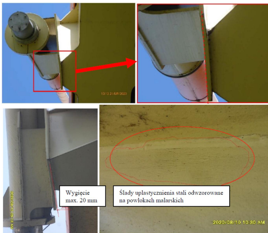
Rys. 3. Przykłady zdeformowanych blach zakotwień wiatru i oznaki przeciążenia.
